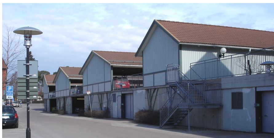
Parkeringsgarage på Garvaren 16.
