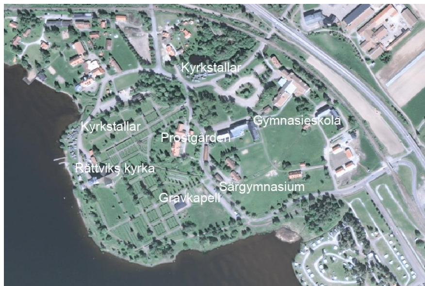
Kyrkudden, översikt. Gymnasieskolans verksamhet fortsätter även på andra sidan riksvägen.
