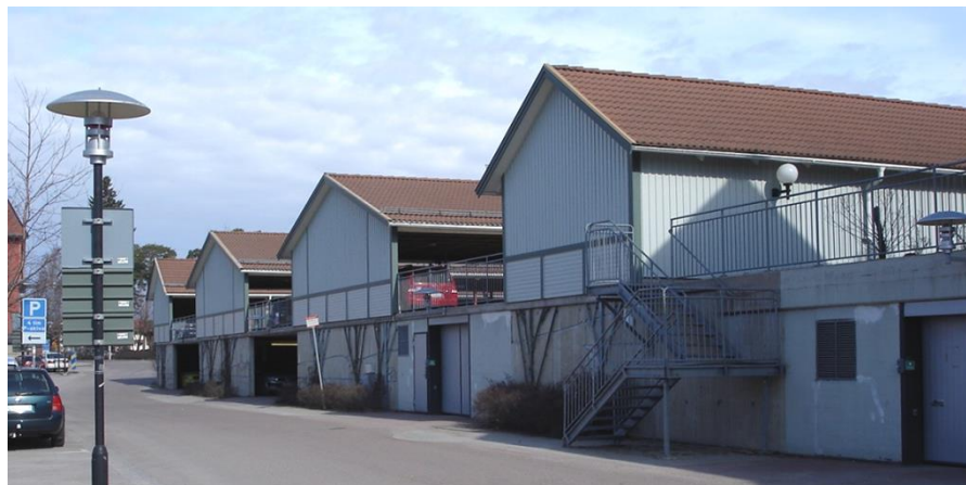
Parkeringsgarage på Garvaren 16.
