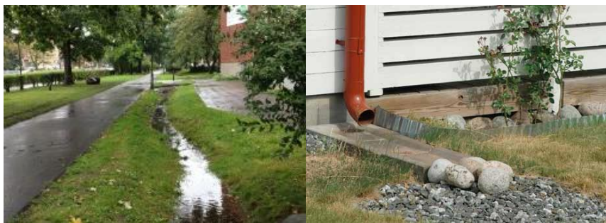
Figur 6. Gräsbeklätt öppet dike (t.v) och stuprörsutkastare (t.h) (Sweden water reaserch, Hudikommun).
