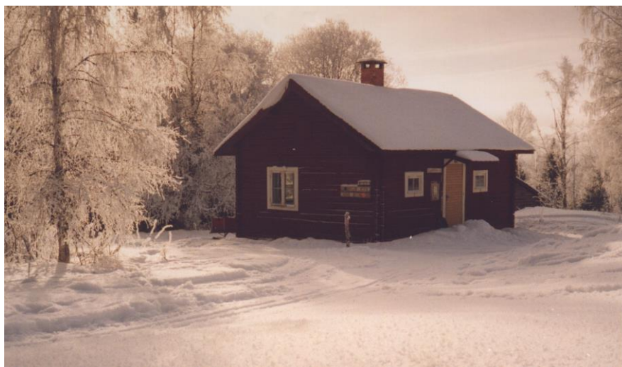
Rast-/värmestugan vid Gunnarsbodarna är uppvärmd 19/2-6/3 2016!
